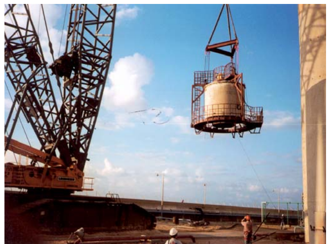
Das abgetrennte Teilstück wird mit Plattform von einem Kran abgehoben.
