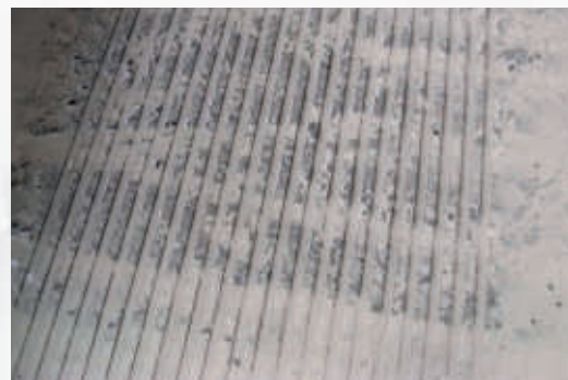
Rillenprofil in einer Betonfläche
